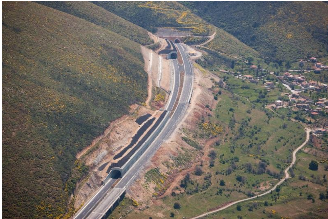
Άποψη : Cut&cover και σήραγγα Ραφομαμάτη
