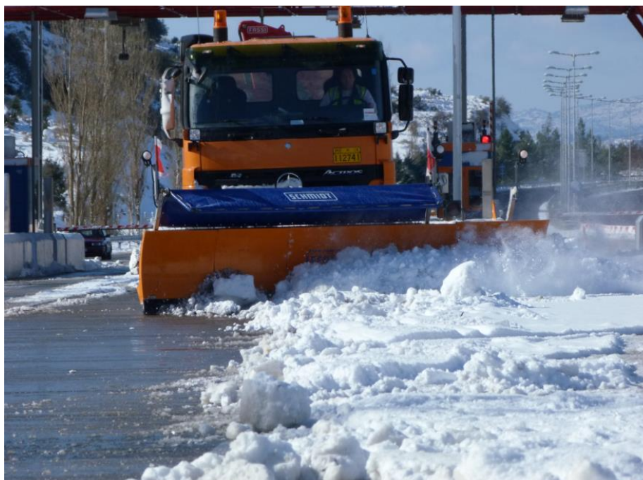
Εικόνα 3: Εργασίες εκχιονισμού σε εξέλιξη.
