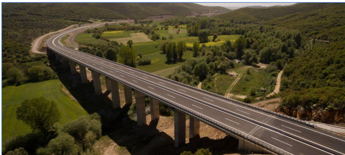
Εικόνα 1: Άποψη της Γέφυρας Ευρώτα (περί τη Χ.Θ. 35+400 του Κλάδου Λεύκτρου – Σπάρτη).
