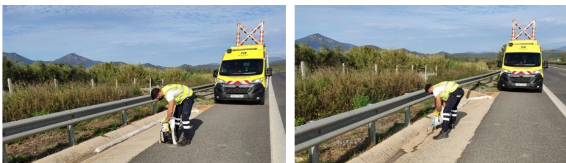
Εικόνα 4: Φωτογραφίες από την Άσκηση Περιβαλλοντικής Ετοιμότητας 2021. Διακρίνονται τα απορροφητικά φράγματα ανάσχεσης ρύπων και η απορροφητική άμμος.
