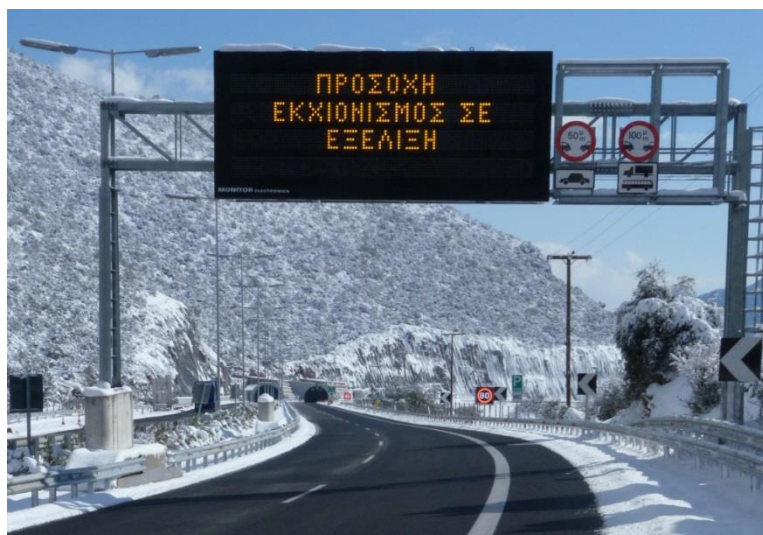
Εικόνα 3: Πινακίδα σήμανσης μεταβλητών μηνυμάτων (VMS) κατά τη διεξαγωγή εργασιών εκχιονισμού.
