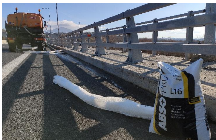
Εικόνα 4: Εικόνα από την Άσκηση Περιβαλλοντικής Ετοιμότητας 2020. Διακρίνονται τα απορροφητικά φράγματα ανάσχεσης ρύπων και η απορροφητική άμμος.
