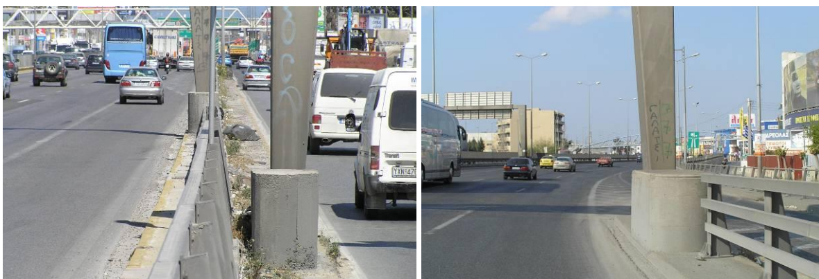
Φωτογραφίες 7.12: Οι βάσεις από σκυρόδεμα μπροστά από τους στύλους των γεφυρών σήμανσης του αυτοκινητοδρόμου αποτελούν επικίνδυνα πλευρικά εμπόδια, καθώς δεν καλύπτονται επαρκώς από τα στηθαία ασφαλείας.
