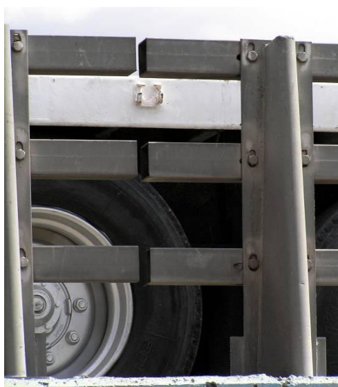
Φωτογραφία 7.6: Έλλειψη σύνδεσης μεταξύ διαδοχικών μεταλλικών δοκών του στηθαίου τύπου ΣΤΕ-1, με σοβαρό κίνδυνο, σε περίπτωση πρόσκρουσης οχήματος στο στηθαίο και παραμόρφωσης αυτού, η δοκός του επόμενου, κατά τη φορά κίνησης, τμήματος του στηθαίου να διεμβολίσει το όχημα.
