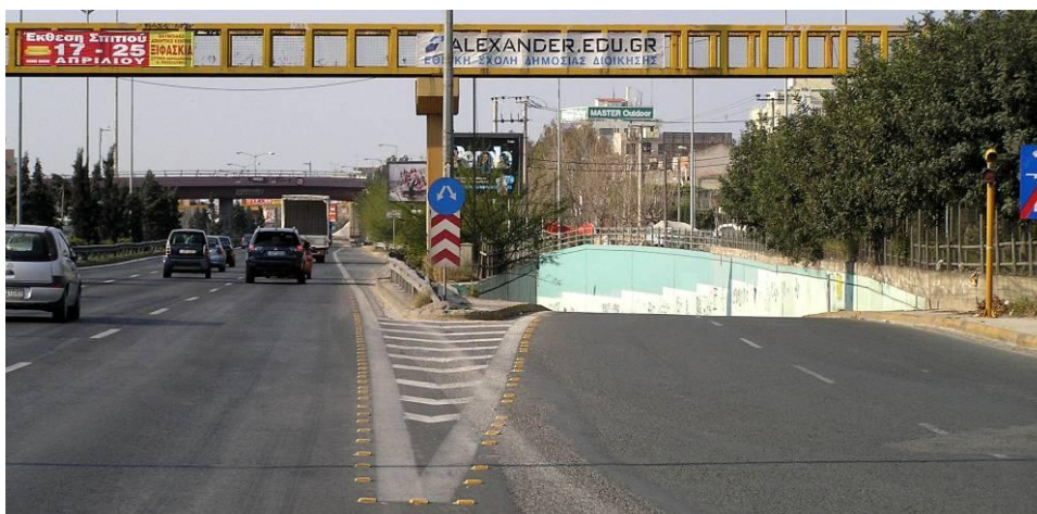
Φωτογραφία 7.9: Μη ασφαλής διαμόρφωση αιχμής και κλάδου εξόδου ανισόπεδου κόμβου. Επισημαίνονται τα προβλήματα ορατότητας - εποπτείας της εξόδου (λόγω του κυρτώματος μικρής ακτίνας στην αρχή του κλάδου) και η μη ασφαλής διαμόρφωση της αιχμής διαχωρισμού και των απολήξεων των στηθαίων ασφαλείας.
