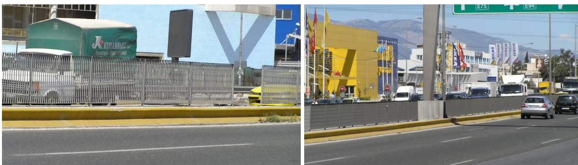
Φωτογραφίες 7.14: Σε αστικό αυτοκινητόδρομο με μεγάλες ταχύτητες κυκλοφορίας έχει κατασκευαστεί κεντρική νησίδα με κράσπεδα επαναφοράς τύπου «trieb» και αντιθαμβωτικό πλέγμα (χωρίς στηθαίο ασφαλείας), με αποτέλεσμα να μην αποτρέπεται επαρκώς η είσοδος οχημάτων στην αντίθετη κατεύθυνση κυκλοφορίας και να μην εξασφαλίζεται επαρκής προστασία από υφιστάμενα εμπόδια (π.χ. γέφυρα σήμανσης στη δεξιά φωτογραφία).
