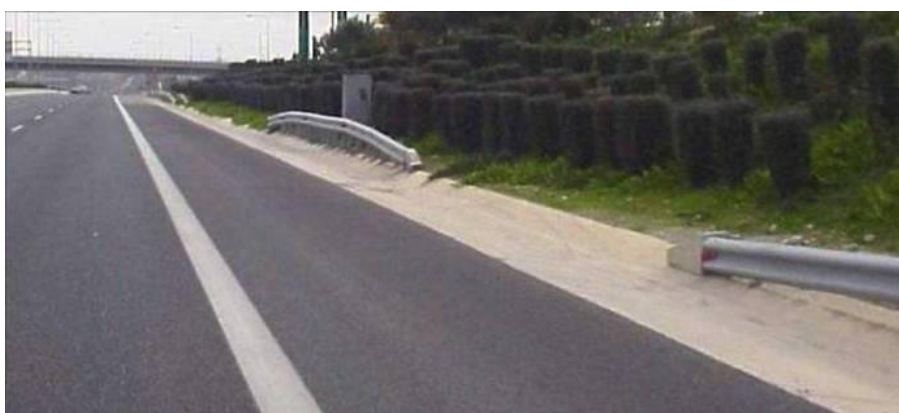
Φωτογραφία 7.4: Οι μικρού μήκους διακοπές στο στηθαίο ασφαλείας, αν και δεν συνιστούν παραβίαση των προβλέψεων των σχετικών Προδιαγραφών, είναι σκόπιμο να αποφεύγονται. Η διαμόρφωση ενιαίου στηθαίου για όλο το τμήμα θα βελτιώσει το παρεχόμενο επίπεδο οδικής ασφάλειας.
