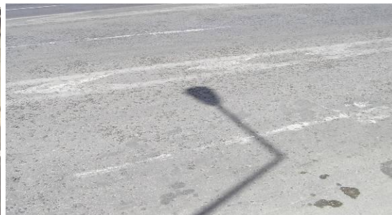
Φωτογραφίες 7.11: Φθαρμένα βέλη κατεύθυνσης και παλιά διαγράμμιση που δεν έχουν αφαιρεθεί (αριστερή φωτογραφία). Δυσδιάκριτη οριζόντια σήμανση (διαγραμμίσεις, βέλη κατεύθυνσης και επιφάνειες αποκλεισμού), λόγω εκτεταμένης φθοράς (δεξιά φωτογραφία).
