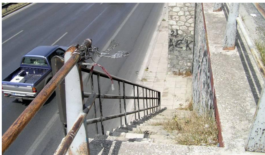
Φωτογραφία 7.10: Η δυνατότητα πρόσβασης πεζών στο οδόστρωμα αστικού αυτοκινητόδρομου μέσω της παραπάνω κλίμακας αποτελεί σημαντικό παράγοντα αυξημένου κινδύνου ατυχήματος. Επισημαίνονται, επίσης, το μη κατάλληλο στηθαίο ασφαλείας στη στέψη του τοίχου στα δεξιά της φωτογραφίας, καθώς και το γεγονός ότι η εσοχή στον τοίχο αντιστήριξης, στη βάση της κλίμακας, συνιστά επικίνδυνο πλευρικό εμπόδιο, για το οποίο δεν έχει τοποθετηθεί στηθαίο ασφαλείας.
