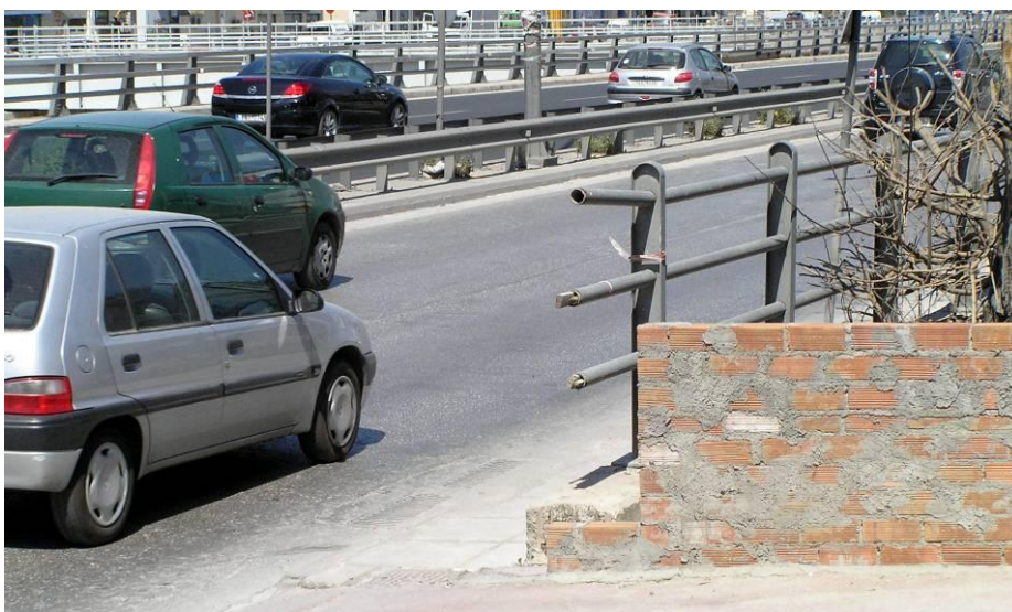
Φωτογραφία 7.2: Ιδιαίτερα επικίνδυνη απόληξη μη κατάλληλου κιγκλιδώματος με οριζόντια στοιχεία, στη δεξιά οριογραμμή κλάδου ανισόπεδου κόμβου, σε αστική αρτηρία στην Ελλάδα.
