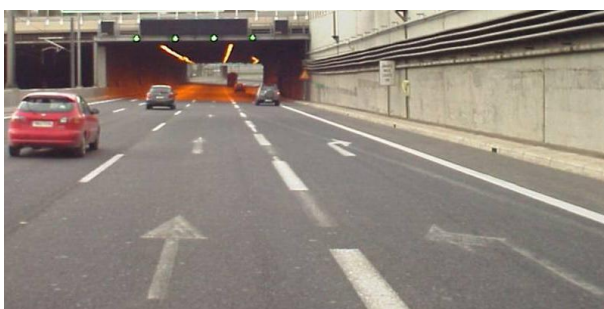
Φωτογραφίες 7.11: Φθαρμένα βέλη κατεύθυνσης και παλιά διαγράμμιση που δεν έχουν αφαιρεθεί (αριστερή φωτογραφία). Δυσδιάκριτη οριζόντια σήμανση (διαγραμμίσεις, βέλη κατεύθυνσης και επιφάνειες αποκλεισμού), λόγω εκτεταμένης φθοράς (δεξιά φωτογραφία).
