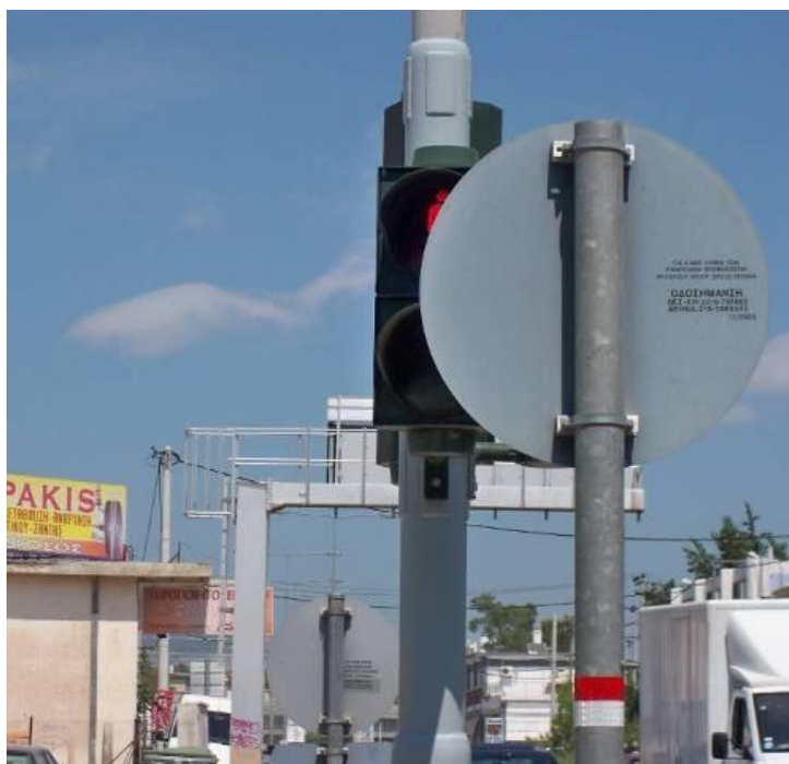
Φωτογραφία 7.15: Απόκρυψη ένδειξης φωτεινού σηματοδότη από πινακίδα σήμανσης.
