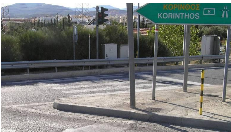
Φωτογραφία 7.16: Η διάβαση πεζών απολήγει εγκάρσια σε μεταλλικό στηθαίο ασφαλείας και δεν υπάρχει δυνατότητα διέλευσης των πεζών.
