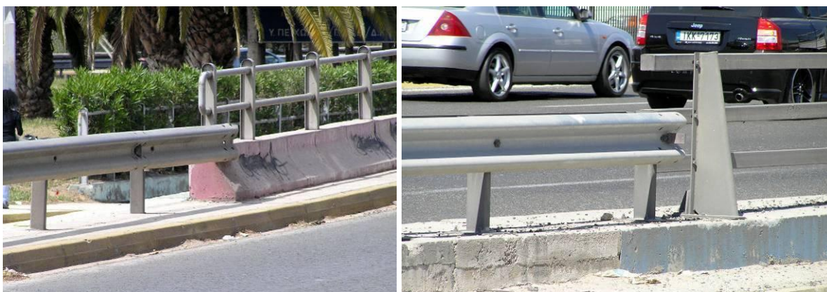
Φωτογραφίες 7.5: Μη ασφαλείς συναρμογές μεταξύ διαφορετικών τύπων στηθαίων ασφαλείας.
