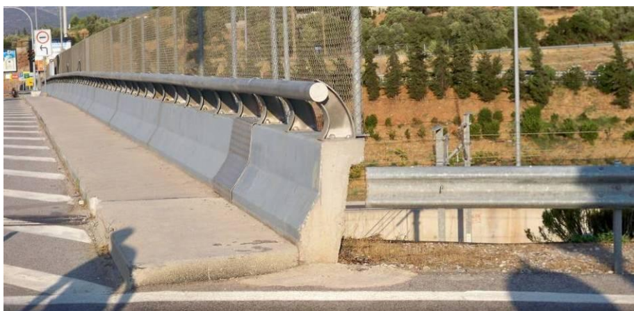
Φωτογραφία 7.3: Έλλειψη στερέωσης του κυματοειδούς ελάσματος του μεταλλικού στηθαίου στο στηθαίο από σκυρόδεμα τύπου ΣΤΕ-9 του τεχνικού έργου Άνω Διάβασης. Επίσης, επικίνδυνη απόληξη του στηθαίου από σκυρόδεμα.
