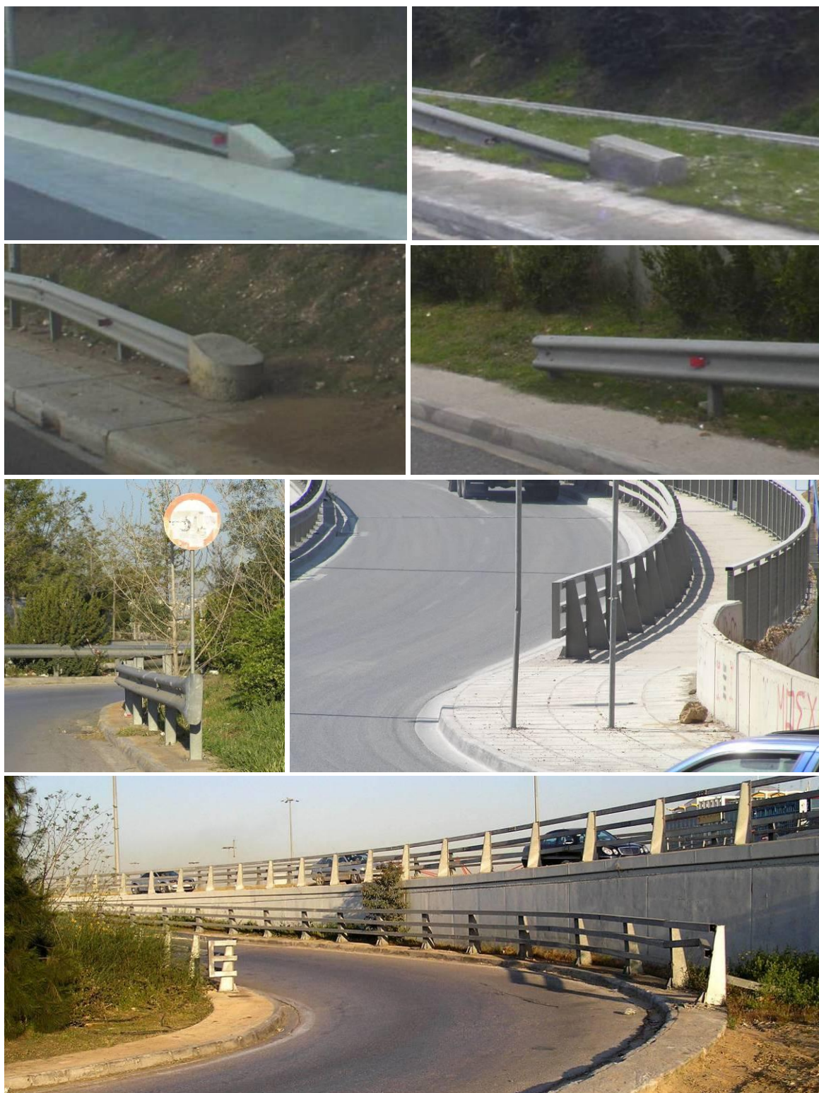
Φωτογραφίες 7.1: Μη ασφαλείς διαμορφώσεις απολήξεων μεταλλικών στηθαίων ασφαλείας, οι οποίες εντοπίστηκαν κατά τη διάρκεια ΕΟΑ σε υφιστάμενες οδικές αρτηρίες στην Ελλάδα.
