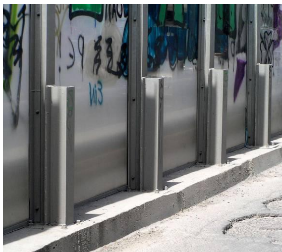
Φωτογραφία 7.13: Σε παράπλευρη οδό αστικού αυτοκινητοδρόμου, οι κατακόρυφες δοκοί στήριξης των ηχοπετασμάτων της αρτηρίας είναι εκτεθειμένες και συνιστούν επικίνδυνο εμπόδιο σε περίπτωση πρόσκρουσης οχήματος αλλά και στην κίνηση των πεζών. Επισημαίνεται, επίσης, η έλλειψη ομαλότητας και οι βλάβες στο οδόστρωμα.
