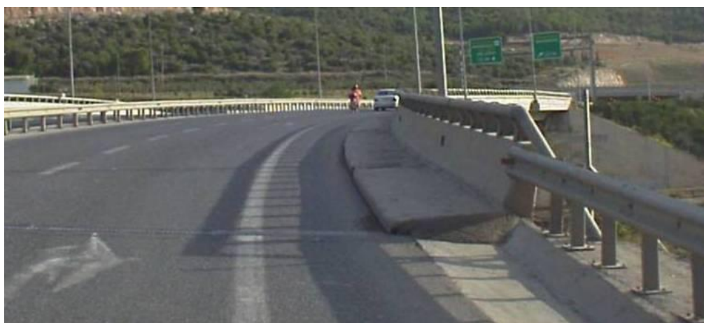
Φωτογραφία 7.7: Μη ασφαλής συναρμογή μεταξύ τριγωνικού ρείθρου και πεζοδρομίου στη δεξιά οριογραμμή κλάδου ανισόπεδου κόμβου. Επίσης, επισημαίνεται η φθαρμένη διαγράμμιση στο οδόστρωμα.
